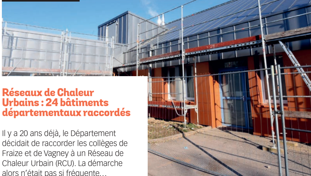
Travaux d'isolation et charpente au collège de Bruyères en mars 2022
